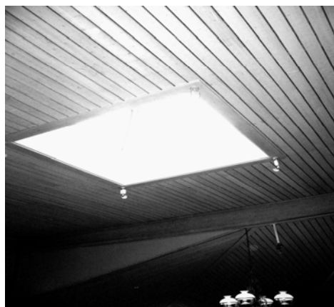
Figur 5.26: Spaltpanel i taket till restaurangen på Konferenscentret Morskogen i Leksand, bestående av brädor med ungefärlig dimension 20x90 mm och dämpning med flätad plastduk (foto Tobias Kirchner).
